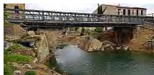
Remplacement d'un pont détruit par une crue
