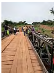
Pont Bailey installé en Centrafrique
