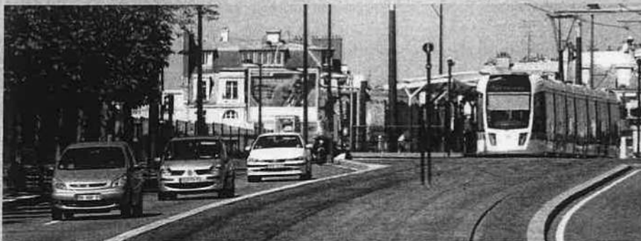
Soutenue financièrement par la Caisse des Dépôts/BDT, l'extension du tramway de Bâle à la gare de Saint-Louis côté français, a été inaugurée en décembre 2017.
