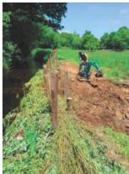
Figure 3 - Réfection d'une berge sur la Penfeld
