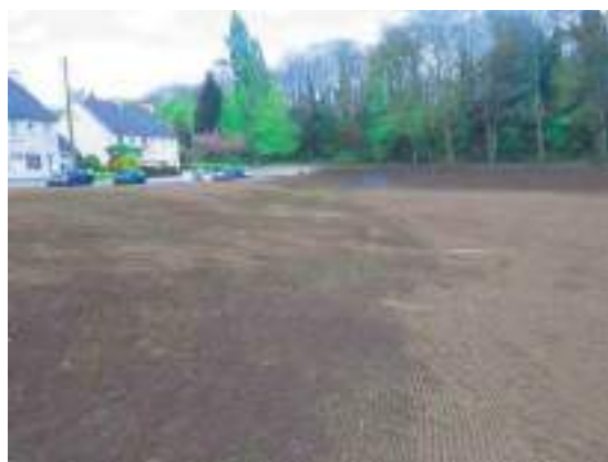
Figure 5 - Création d'une zone d'expansion de ruisseau - Après travaux
