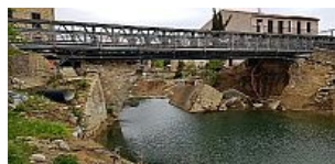
Remplacement d'un pont détruit par une crue
