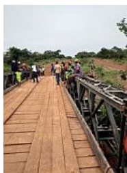
Pont Bailey installé en Centrafrique
