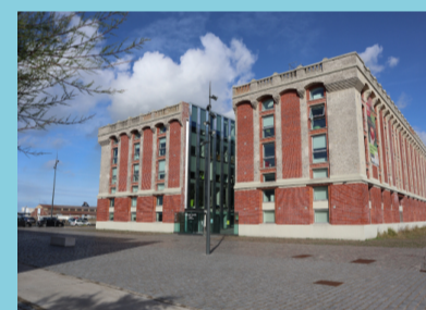
Centre de formation Halle aux sucres Dunkerque
