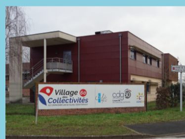
Antenne de l'Oise à Beauvais
