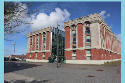
Centre de formation Halle aux sucres Dunkerque
