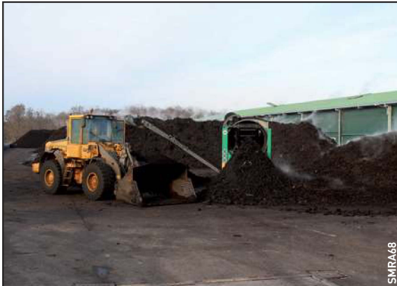
Plateforme de compostage des boues
