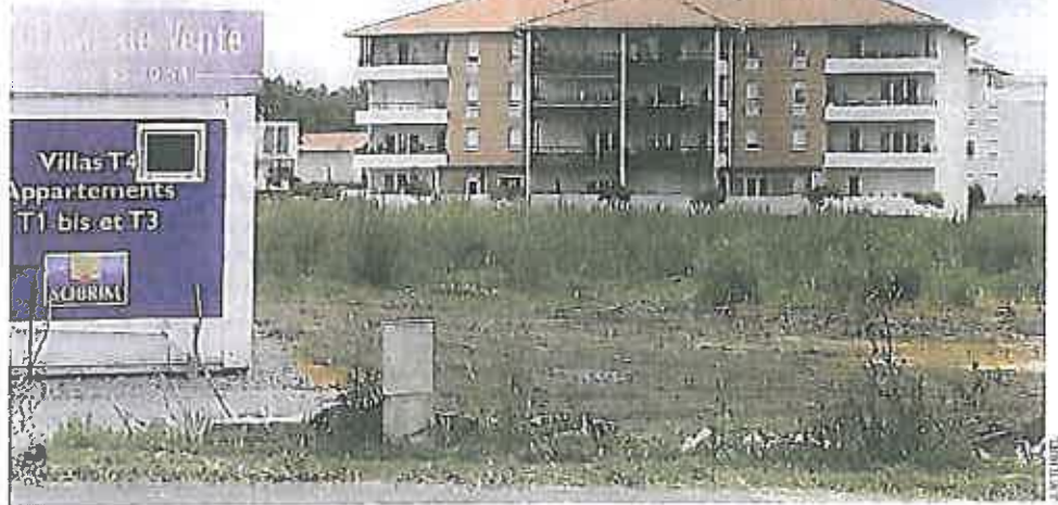
La convention de PUP précisera les équipements publics induits, la date d'achèvement du projet, l'apport de fonds par les partenaires...
