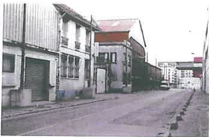
En face, parcelles de la rue des Fillettes où, après démolition, sera construite une partie de la première phase du Campus Condorcet en PPP. Au fond à droite, la Maison des Sciences de l'Homme (rose) en construction hors PPP.
