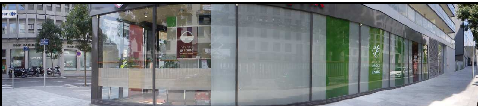
Le supermarché du croisement cours Emile Zola / rue Marcel Bontemps occupe les lots 28 à 32. Une partie de son linéaire de vitrine est opacifié. ©N. Svahnström
