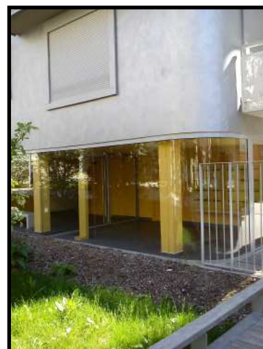
Un hall d'immeuble donnant sur la traverse ©N. Svahnström
