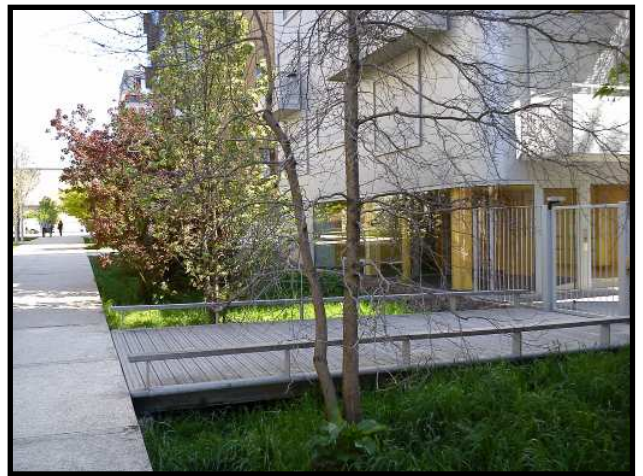
Une noue sur l'allée Robert Doisneau (îlot A3). ©N.Svahnström
