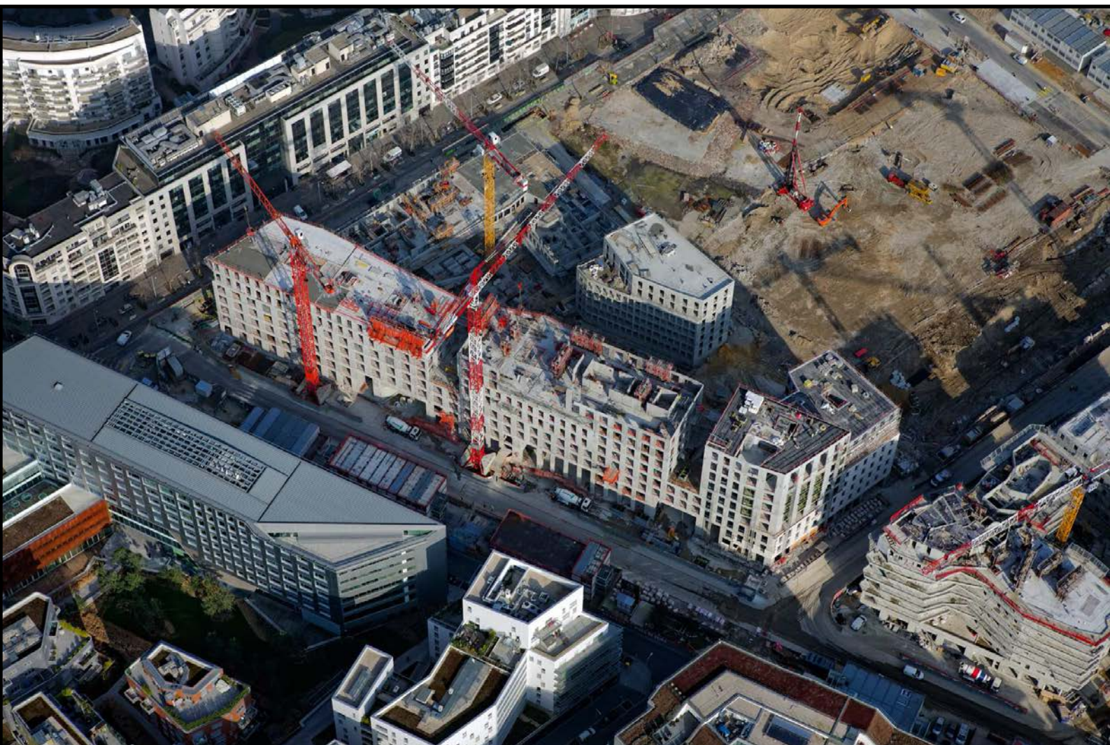
Chantier sur l'îlot A4. ©G. Halary
