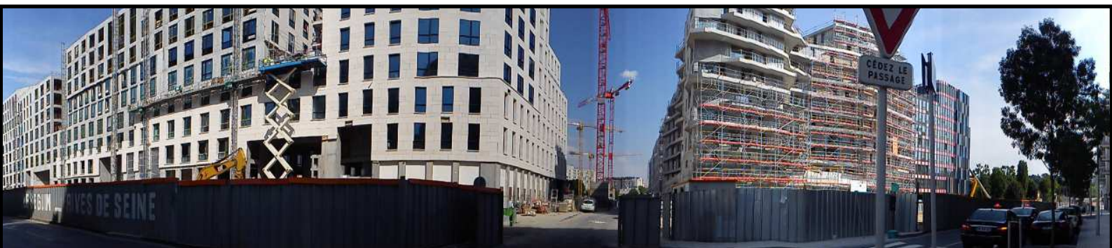
Chantiers des îlots A4 et B4 sur le flanc Est du croisement Cours Emile Zola / Rue Marcel Bontemps, auxquels font face les locaux commerciaux des îlots A3 et B3 déjà livrés et prêts à être commercialisés et exploités. ©N. Svahnström
